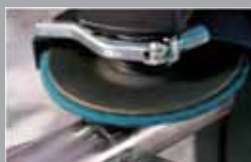
Шлифование сварных швов и удаление термического налета
